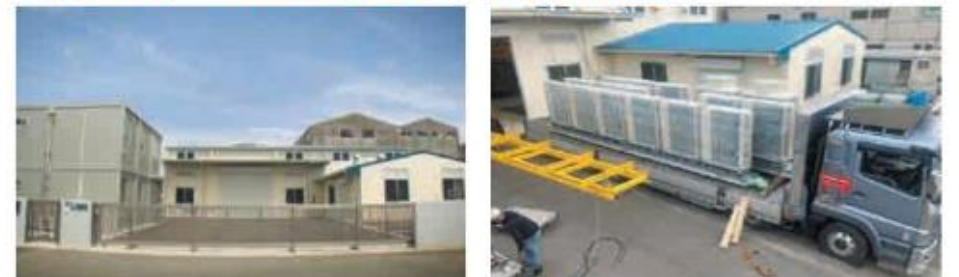
施設外観 搬出される加工済み空調室外機ユニット
